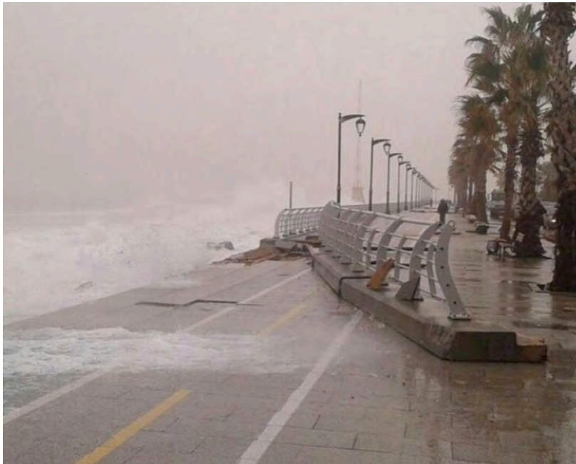
Image 2: Le dégât de l'infrastructure à Ain El Mreisseh au Liban durant l'orage de l'hiver 2015 [8]
